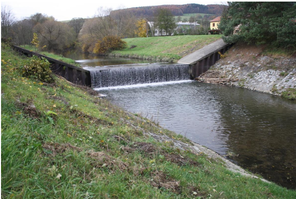
Obr. 20: Larzenový jez Popov v řkm 22,778 – úprava jezu na betonový práh ve dně
