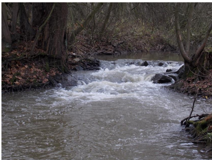
Obr. 2: Migračně prostupný stabilizační stupeň – Jaroměřice n/R., řkm 70,493 (pohled proti toku)
