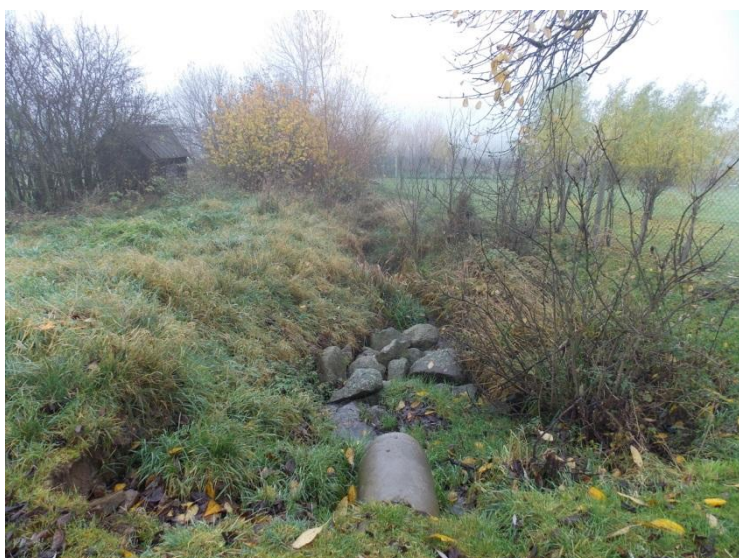
Obr. 11: Migračně neprostupná hráz nádrže Veverka řkm 87,224 (pohled po toku)
