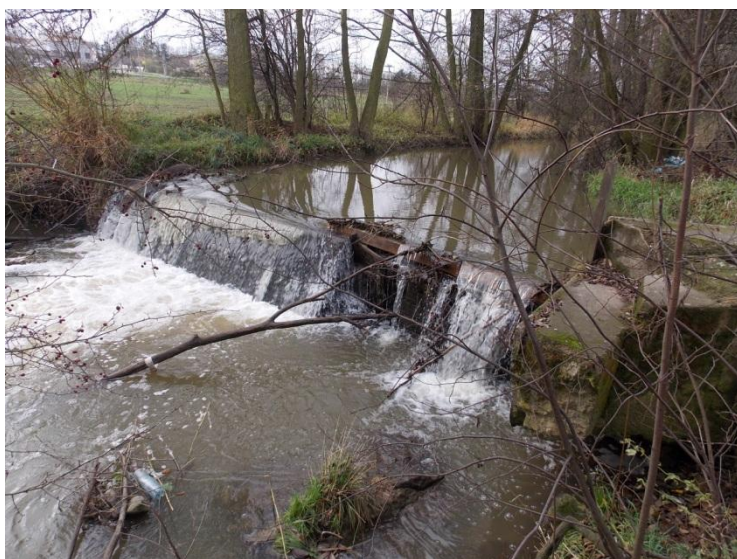
Obr. 3: Jez (odbočení do LB náhonu) – Popovice n/R., řkm 71,666 (pohled proti toku)
