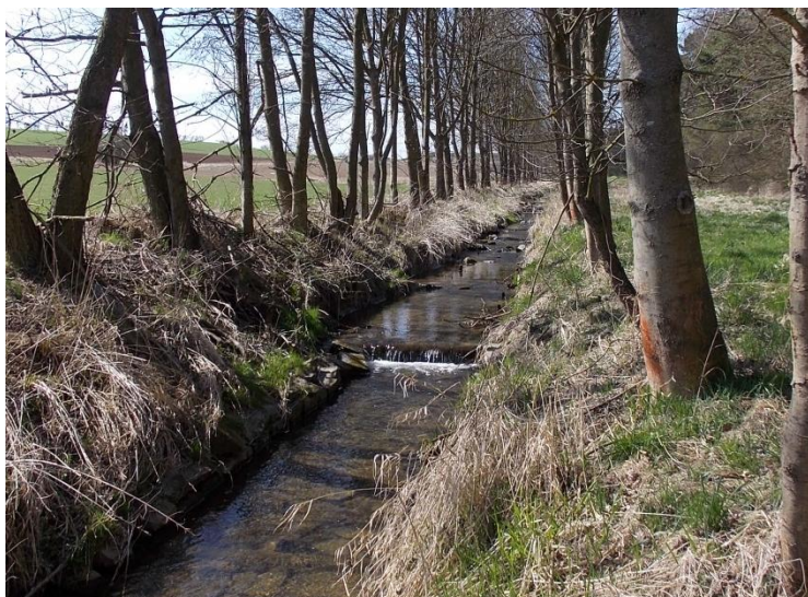
Obr. 10: Migračně prostupný stabilizační stupeň mezi Kojeticemi a Rokytnicí řkm 81,856 (pohled proti toku)
