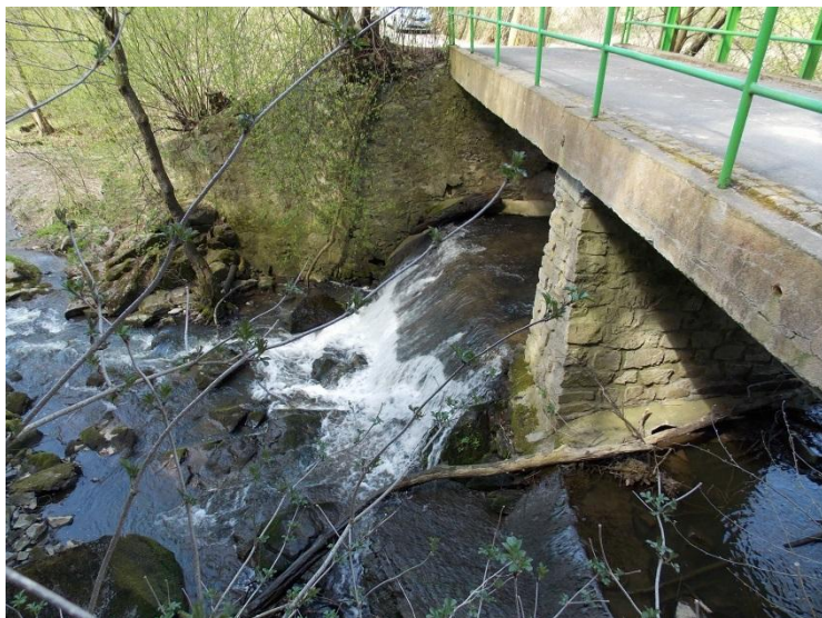
Obr. 7: Stupeň, bývalá rybníční hráz – U Újezského mlýna, řkm 77,466 (pohled proti toku)
