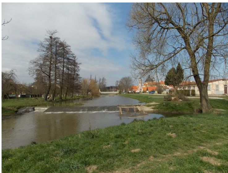
Obr. 1: Pevný jez – Jaroměřice-město, řkm 69,196 (pohled proti toku)
