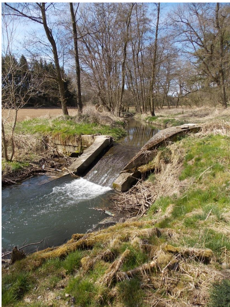
Obr. 8: Jez s LB odběrem – pod Šibeným řkm 79,370 (pohled proti toku)
