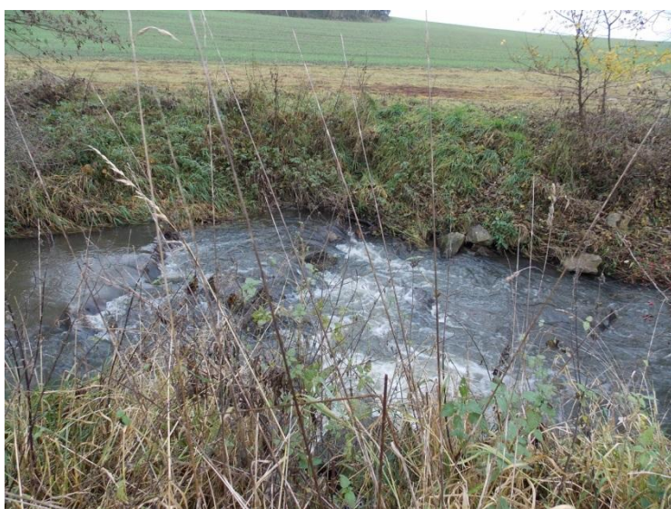
Obr. 6: Migračně prostupný kamenný stupeň (balvanitý skluz) Pod Újezdským mlýnem nad úpravou řkm 77,133 (pohled proti toku)
