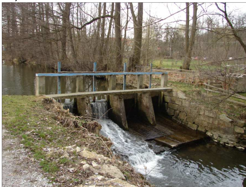
Obr. jezová konstrukce v Žatci
