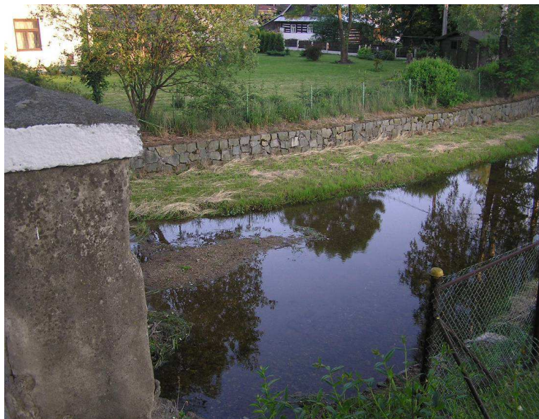
Obr. 8 Regulované koryto a ukládání splavenin u historického mostu v Herálci
