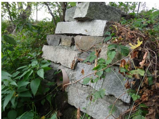
ř. km cca 18,78 - vlevo po proudu - kamen. kvádry a betonem stabilizovaná kanaliz. výúst, v pozadí oplocení areál fy Podravka
