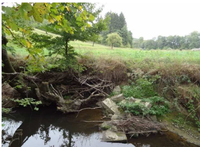
km cca 17,39 - po proudu - opevnění podemletého pr. břehu stavebním odpadem, v pozadí svah s ovocnými stromy
