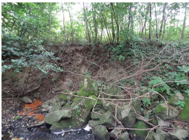
km cca 17,45 - proti proudu - opevnění břeh. nátrže lom kamenem (bez vazby) v blízkosti silnice
