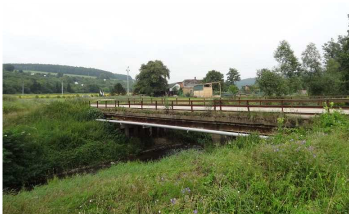
ř. km cca 0,615 - proti proudu - hospodářský most, koryto - dvojitý lichoběžník, bez vegetač. doprovodu, v pozadí - pb. areál motorestu, železnice a silnice
