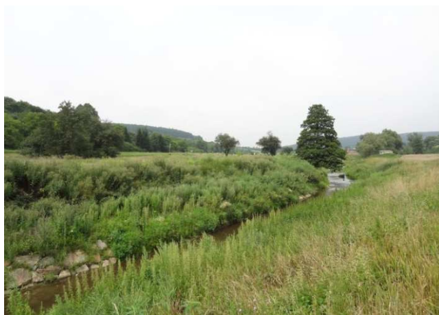
ř. km cca 0,40 - proti proudu - upravené koryto, dvojitý lichoběž., pata kynety s těžkým opevněním, bez vegetač. doprovodu, v pozadí - pb. železnice a silnice, lb. polní cesta a pole
