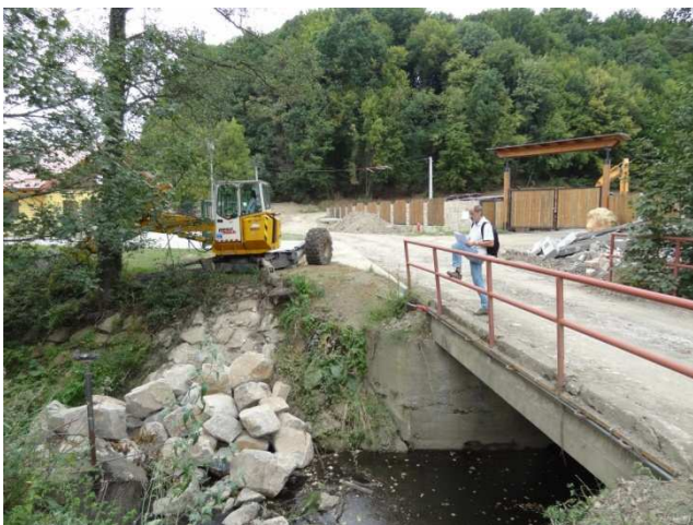
ř. km cca 18,33 - vlevo po proudu - příjezd. most k ČOV, zpevňování břehu kamen. kvádry
