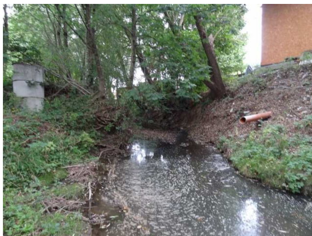
ř. km cca 18,67 - proti proudu - lb. tvořený navážkou, bez vegetace, kanaizl. výúst, vlevo kanaliz. šachta (shybka?)
