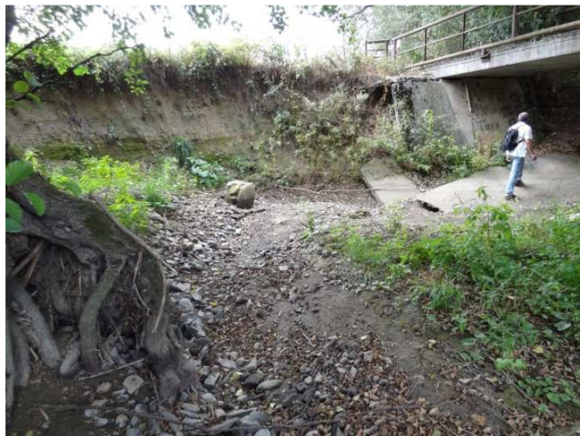
ř. km cca 23,55 – proti proudu – beton. mostek se zdevastovaným beton. opevněním svahů, za mostkem prudký oblouk doleva (podemletý břeh)
