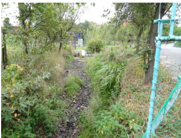
ř. km cca 24,37 – proti proudu – úzké lichoběžník. koryto, nesouvisle opevněné, v pozadí prudký oblouk
