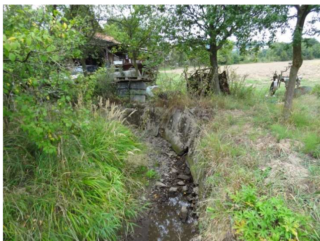
ř. km cca 24,35 – proti proudu, okraj zástavby – beton. opěrná zídka na pb. (prudký oblouk)
