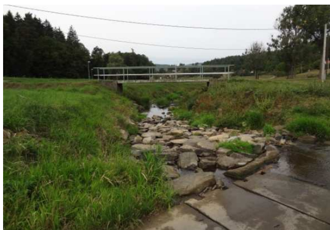
ř. km cca 16,21 - po proudu - panely zpevněný brod a balvan. skluz do nádrže, v pozadí lávka a vtok do nádrže
