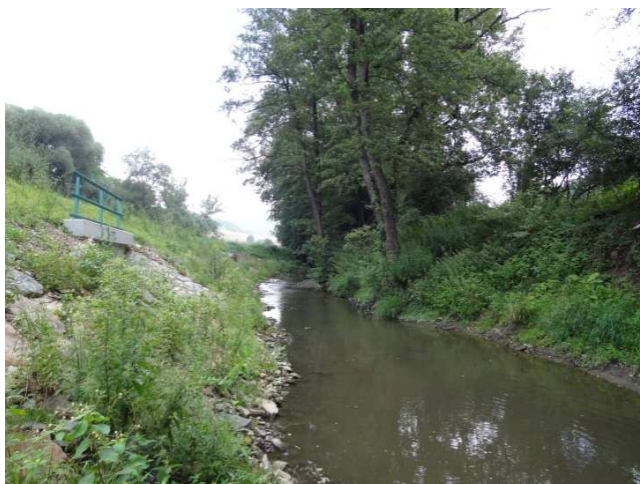
ř. km cca 2,75 - proti proudu - pb. opevněn kamenem, bez vegetace, vyústění propustků pod železnicí a silnicí, lb. i pb. shodné výšky, hladina na celou šířku dna
