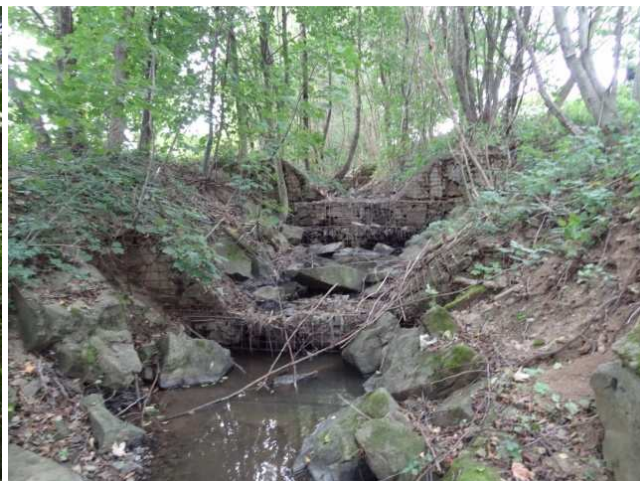
ř. km cca 23,18 – Luh. potok zprava do leva – ústí Horní Olšavy (drátokamen. stupně, těžké opevnění)
