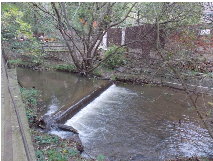
Obr. 03: Stupeň v Rosicích (řkm 26,257), migračně neprostupný
