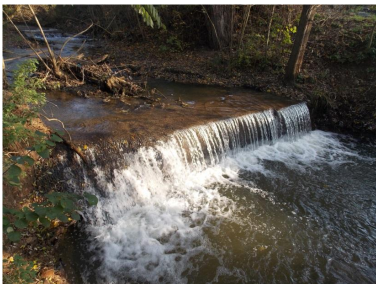
Obr. 02: Stupeň v Tetčicích (řkm 24,194), migračně neprostupný
