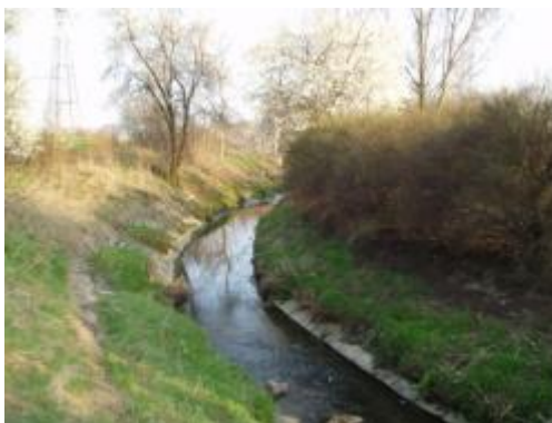
Koryto nad potrubím bylo zpevněno betonovým opevněním
