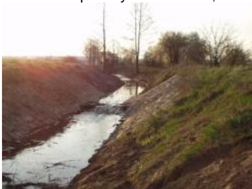
Pohled ke konci úseku, kde je zatím provedeno odtěžení nánosů.
