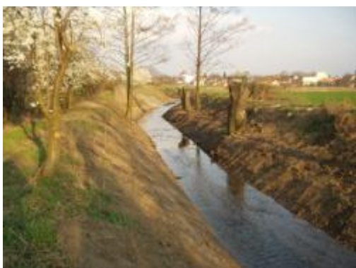
Pohled ke konci úseku, kde je zatím provedeno odtěžení nánosů.
