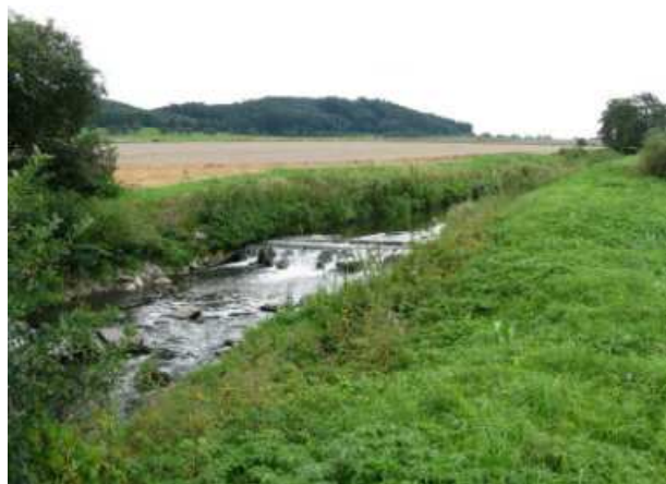
Obr. 34 – Stabilizační stupeň
