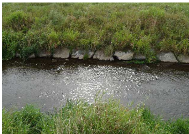
Obr. 12 – Zbytky opevnění paty
