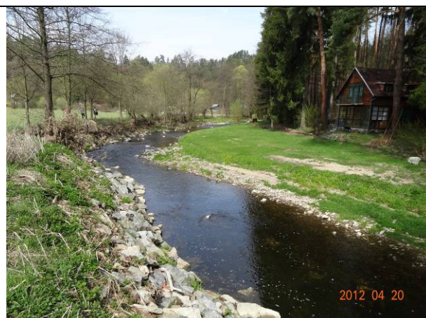
Obr.15. – opevněný pravý břeh v ř. km 6,398 – 6,837
