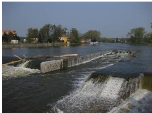
Obr. 32: RP Břeclav na řece Dyji, délka 68m, spád 1:20 návrhový průtok 2 \text{ m}^3/\text{s} , realizace 2005 - 2008
