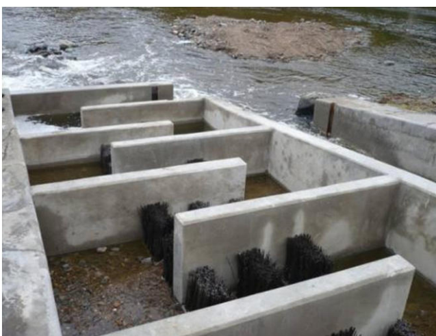
Obr. 39: příklad specifického technického řešení RP ve stísněných podmínkách cik-cak vedení trasy ve vorové propusti (Sázava, jez Kavalier) - může být využito stejně i pro štěrbinový RP
