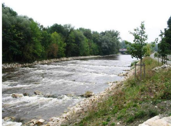
Obr. 30: příklad odstranění jezu - řeka Vertach, Ausburk, Německo (foto Ing. Just)
