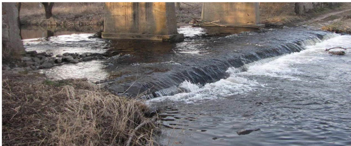
Obr. 41: Ukázka migračně neprostupného brodu z kamenné dlažby na řece Rokytné – malá hloubka vody na vlastním tělese brodu a velký rozdíl hladin v důsledku vytvoření výmolu pod koncem opevnění.
