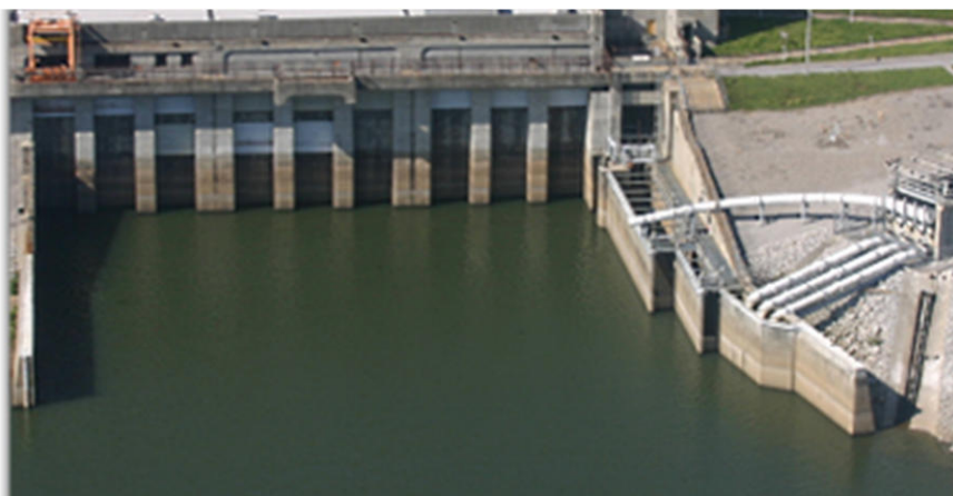
Obr. 43: Na obrázku vlevo pohled na celou hráz nádrže, rybí přechod s potrubími pro přídavný lákavý proud je lokalizován u levého břehu, na obrázku vpravo je detail vstupu do výtahu.
