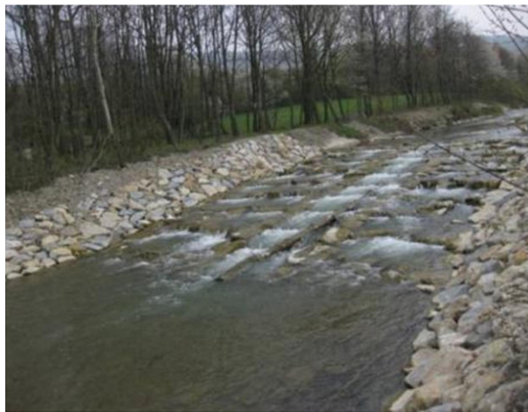
Obr. 31: Balvanitý skluz na řece Velička s kynetou uprostřed
