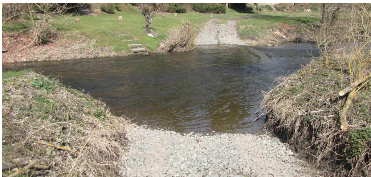
Obr. 40: Ukázka migračně prostupného štěrkového brodu na řece Rokytné – hloubka vody v brodu je dostatečně velká a převýšení hladin nepřekračuje 5 cm. Díky hloubce brod není vhodný pro běžná vozidla.
