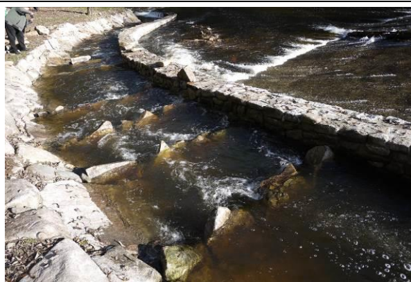
Obr. 28: RP Pstruhařství Kaplice na řece Malši, realizace 2014 – vstup do přechodu doplněn o naváděcí práh
