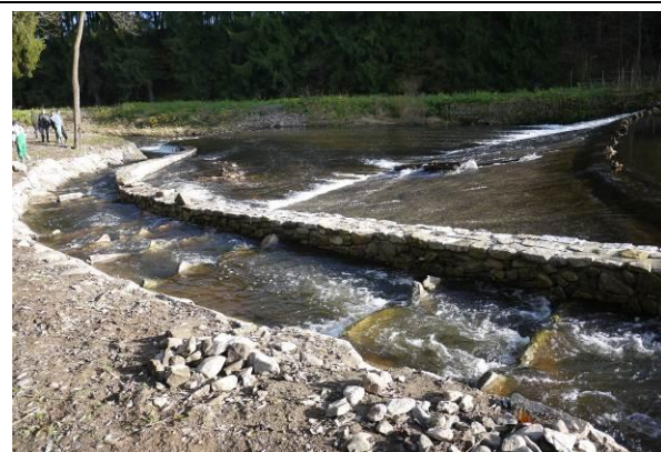
Obr. 28: RP Pstruhařství Kaplice na řece Malši, realizace 2014 – vstup do přechodu doplněn o naváděcí práh
