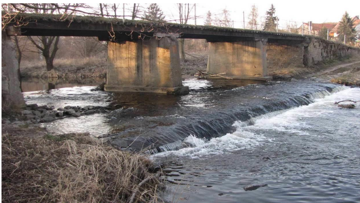
Obr. 35: Ukázka migračně neprostupného brodu z kamenné dlažby na řece Rokytne – malá hloubka vody na vlastním tělese brodu a velký rozdíl hladin v důsledku vytvoření výmolu pod koncem opevnění.
