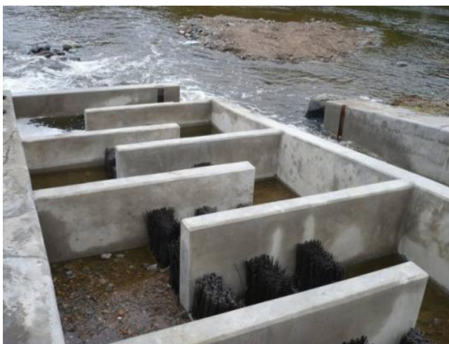
Obr. 33: příklad specifického technického řešení RP ve stísněných podmínkách cik-cak vedení trasy ve vorové propusti (Sázava, jez Kavalier) - může být využito stejně i pro štěrbinový RP
