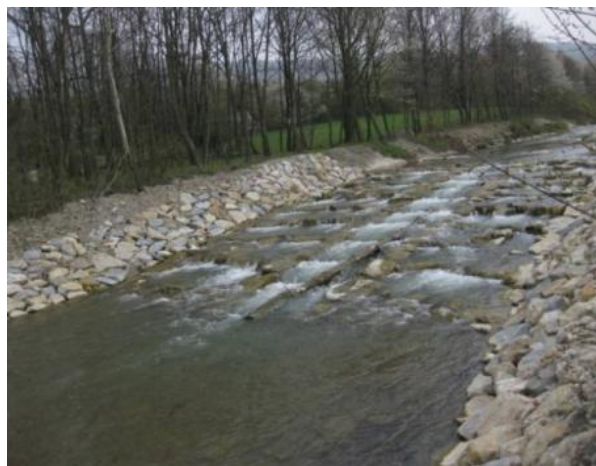
Obr. 25: Balvanitý skluz na řece Velička s kynetou uprostřed
