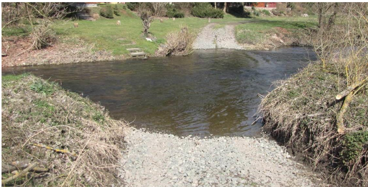
Obr. 34: Ukázka migračně prostupného štěrkového brodu na řece Rokytne – hloubka vody v brodu je dostatečně veliká a převýšení hladin nepřekračuje 5 cm. Díky hloubce brod není vhodný pro běžná vozidla.
