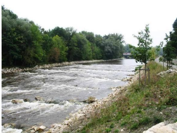
Obr. 24: příklad odstranění jezu - řeka Vertach, Ausburk, Německo (foto Ing. Just)
