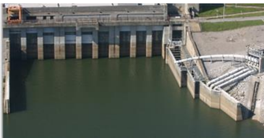
Obr. 37: Na obrázku vlevo pohled na celou hráz nádrže, rybí přechod s potrubími pro přídavný lákavý proud je lokalizován u levého břehu, na obrázku vpravo je detail vstupu do výtahu.
