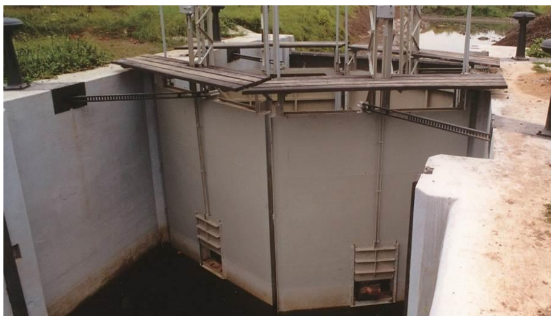
Obr. 39: Vzpěrná vrata plavební komory Strážnice s instalovanými hrazenými otvory.
