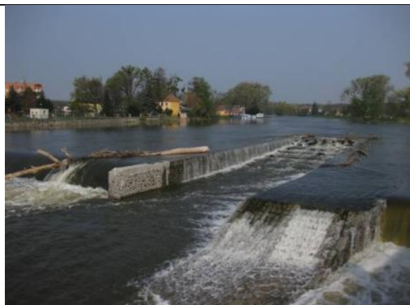
Obr. 26: RP Břeclav na řece Dyji, délka 68m, spád 1:20 návrhový průtok 2 \text{ m}^3/\text{s} , realizace 2005 - 2008
