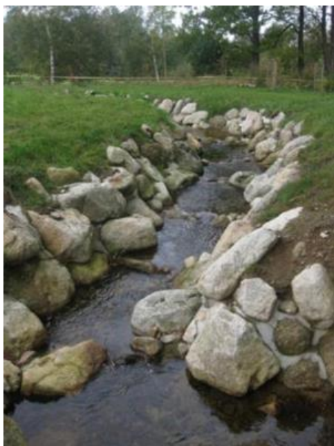
Obr. 30: RP Bypas na Bílém potoce, Jizerské hory, délka 60 m, spád 1:20, návrhový průtok 50 l, rok dokončení 2009
